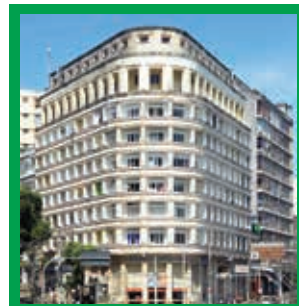
Edifício Sulacap, Salvador (Processo nº 0607080035510);
