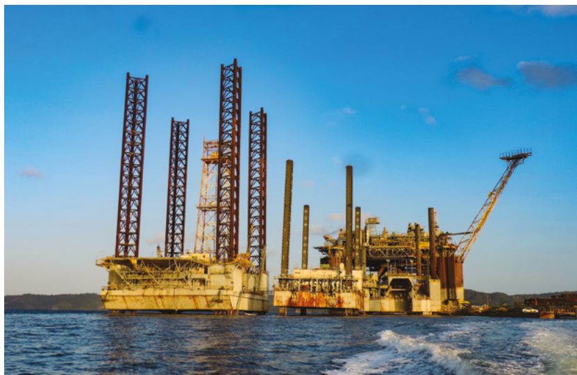
FOTOGRAFIA 18 – Pier e canteiro de obras em São Roque do Paraguaçu Fotografia da autora, Enseada do Paraguaçu, 2013.
