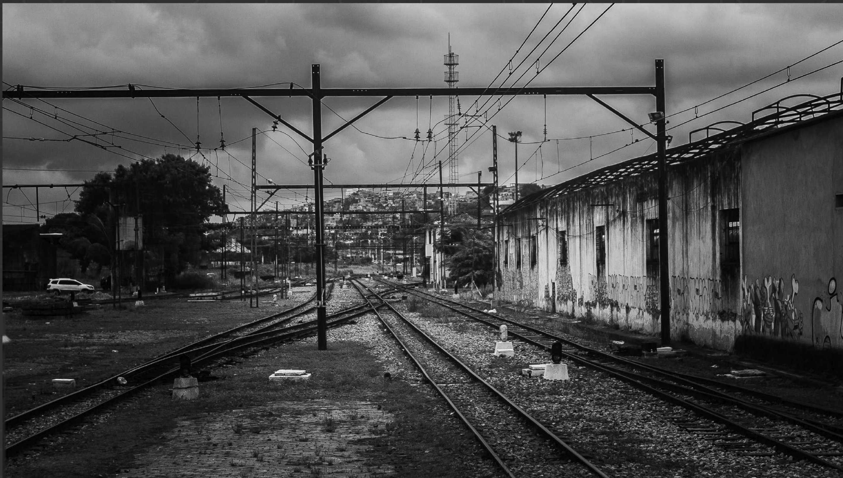
ESTAÇÃO DE TRENS DA CALÇADA SALVADOR-BAHIA-BRASIL, MARÇO /2020
