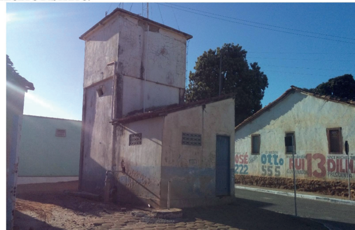
Figura 5: ANTIGA CAIXA D'ÁGUA COM BOMBA ELÉTRICA QUE ABASTECIA O DISTRITO.
