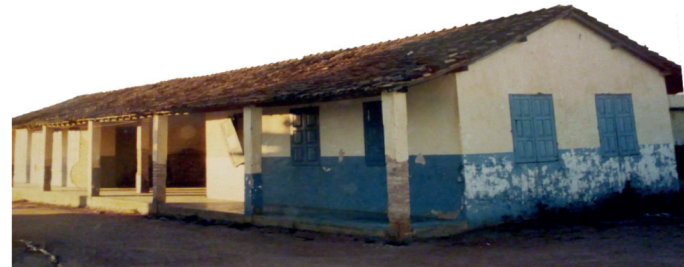
Figura 18: PRIMEIRA SEDE - ANTIGA ESCOLA ESTADUAL DE MANIAÇU-DEMOLIDA.
